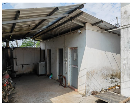
施工区卫生间
