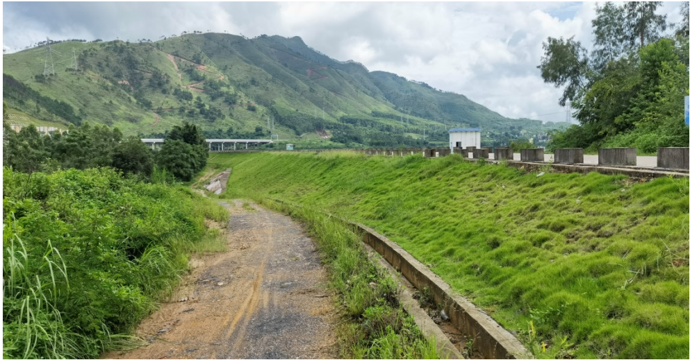
图 7-3 坝坡背水坡草皮绿化现状 1
