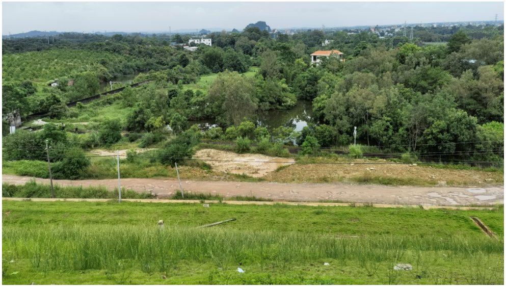
图 7-2 2#弃渣场生态恢复现状
